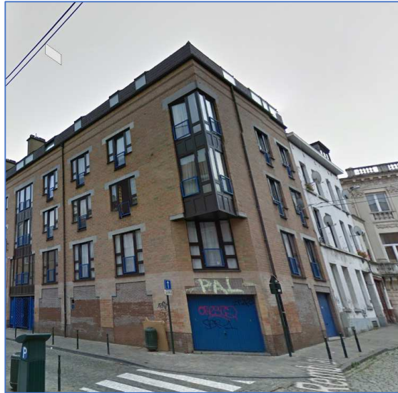
Bâtiment au coin de rue du Remblai et rue de la Philanthropie.
